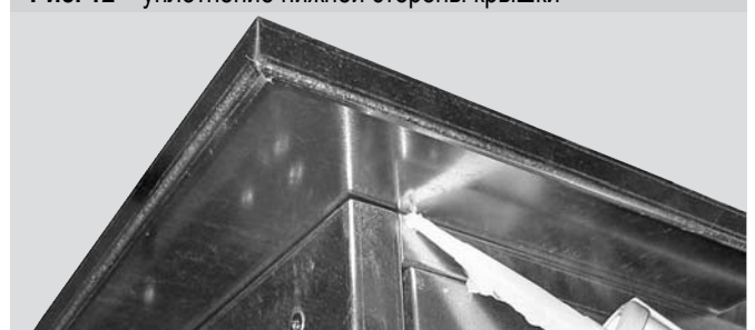
Рис. 12 – уплотнение нижней стороны крышки
