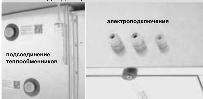
Рис. 8 – подвод энергоносителей
