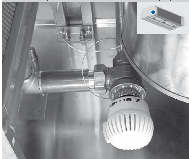
Рис. 14 – термостатический вентиль TVW-R (D2)
