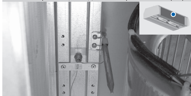
Рис. 17 – размещение датчика термовентилля (D2)
