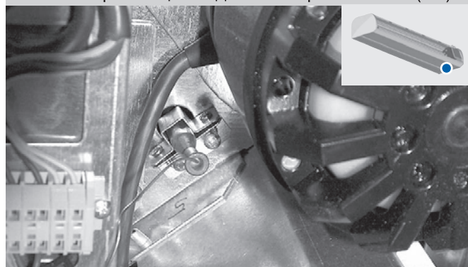
Рис. 16 – размещение датчика термовентилля (C1)
