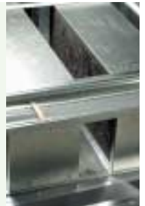
Внутреннее шумопоглощение шумоглушителя
